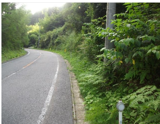
津具地区 農道(法面)改良工事 着手前
