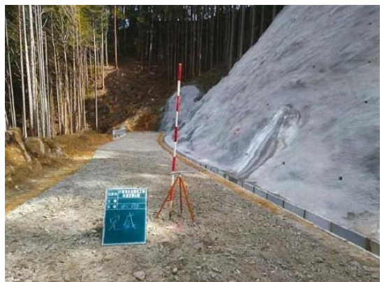
林道笹頭山線 開設状況
