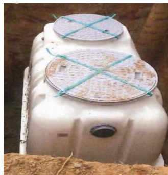
合併浄化槽の設置
