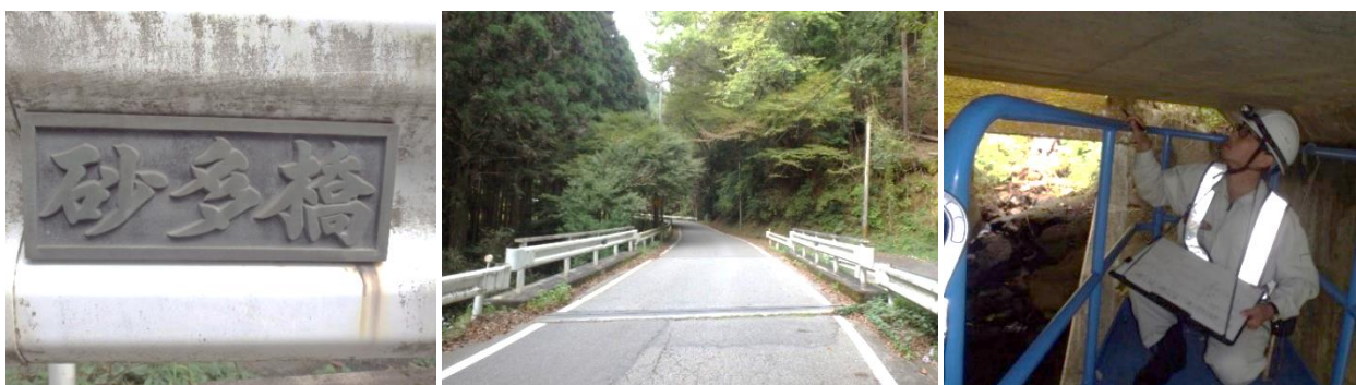
砂多橋（田峯地内）点検の様子
