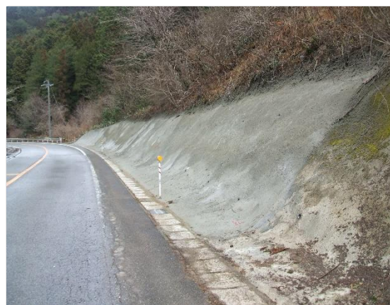
津具地区 農道(法面)改良工事 完了
