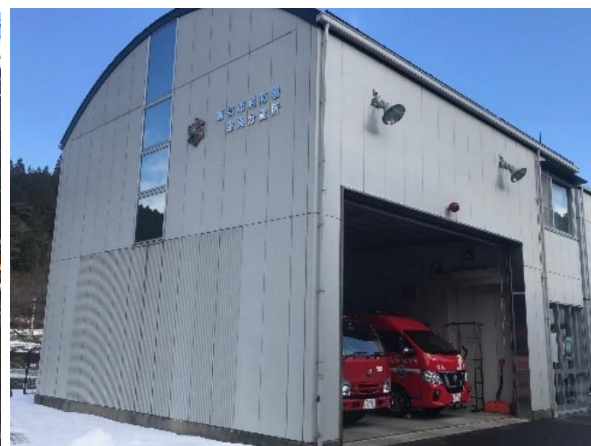
新城市消防署津具分遣所
