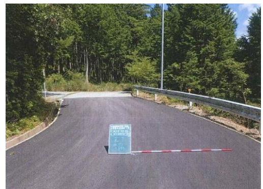
林道根道外線 舗装状況
