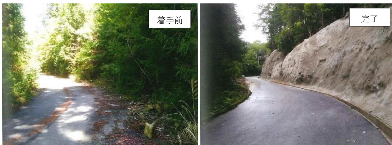
法面改良工事を進める林道田内野平線（田峯地内）
